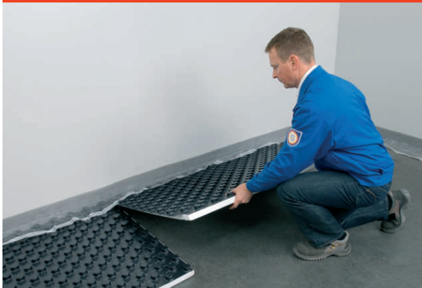
Obr. 5: Spojenie nopových prvkov
