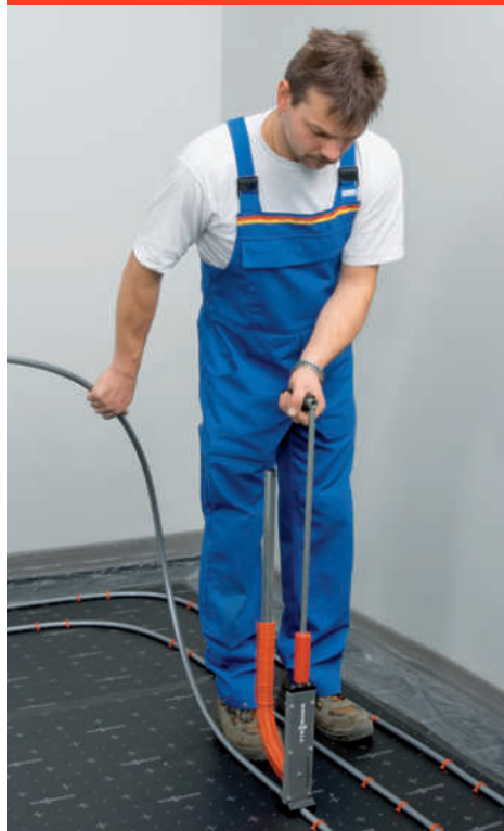
Obr. 17: Kotviace sponky rúry tesne obopnú
