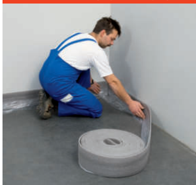
Obr. 14: Pokládka okrajových izolačných pásov
