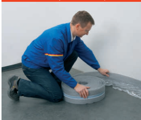
Obr. 2: Pokládka okrajového izolačného pásu
