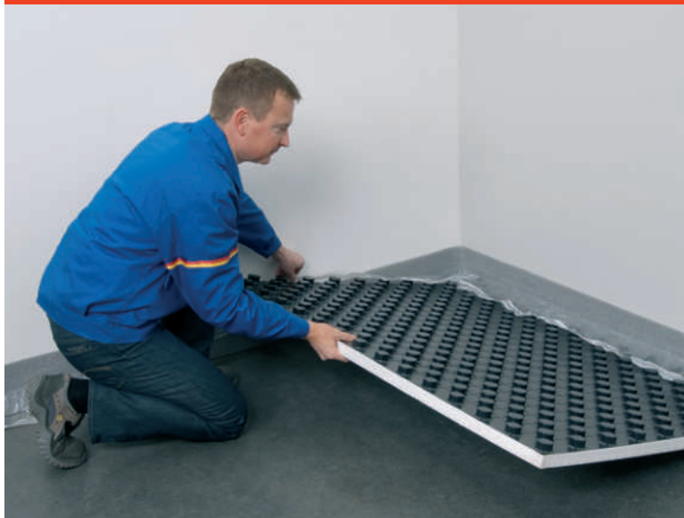
Obr. 4: Pokládka nopového prvku
