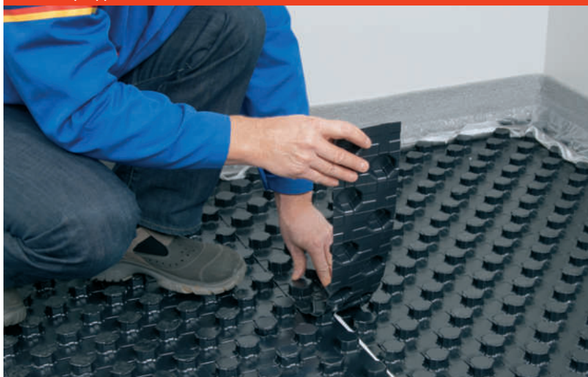
Obr. 6: Nopový prvok narežte „na mieru“
