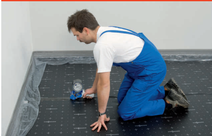
Obr. 16: Prekrytie lepiacou páskou
