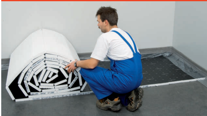
Obr. 15: Pokládka spojovacieho materiálu
