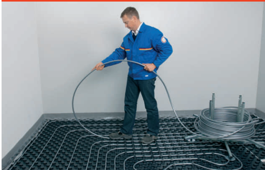
Obr. 9: Vykurovaciu rúru systému Vitoset položte na nopové prvky
