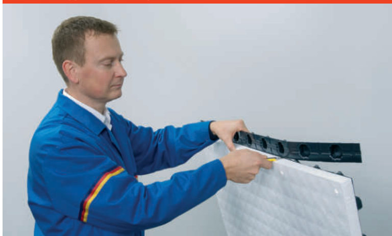
Obr. 3: Fóliový presah nopového prvku treba odrezat'
