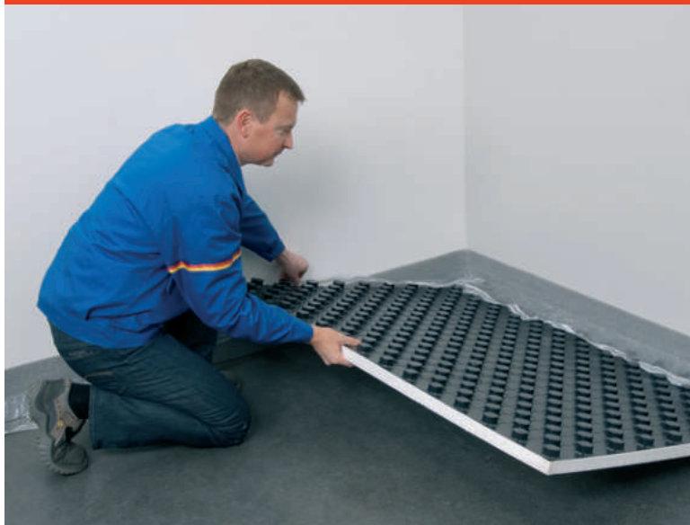
Obr. 4: Pokládka nopového prvku
