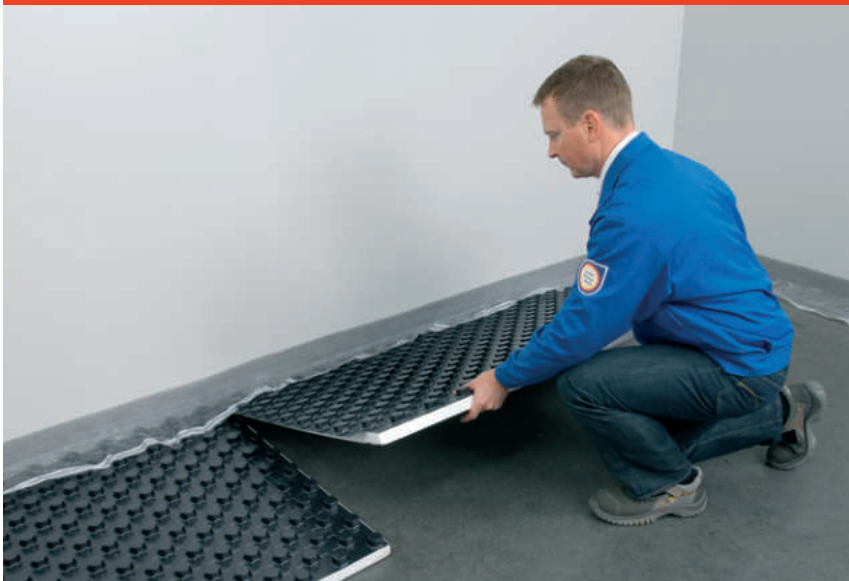
Obr. 5: Spojenie nopových prvkov
