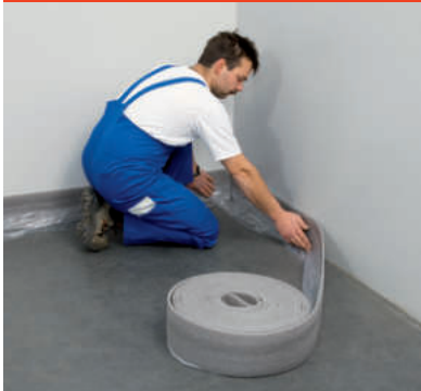
Obr. 14: Pokládka okrajových izolačných pásov
