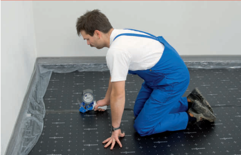
Obr. 16: Prekrytie lepiacou páskou
