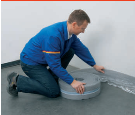
Obr. 2: Pokládka okrajového izolačného pásu
