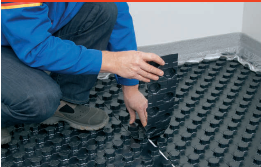
Obr. 6: Nopový prvok narežte „na mieru“
