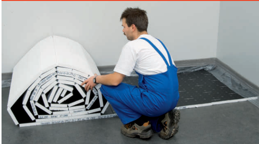
Obr. 15: Pokládka spojovacieho materiálu
